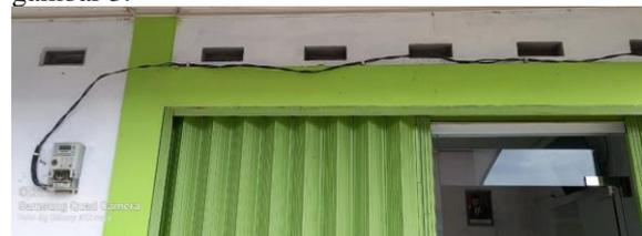
Gambar 3 Posisi pasang alat pembatas pengukur (APP) 1 fasa
