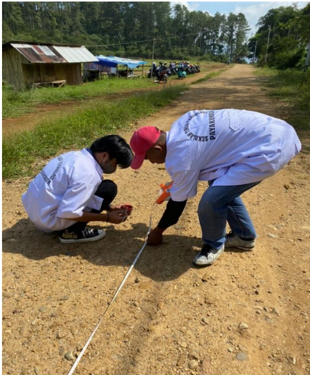
Gambar 3. Pengukuran Poligon terbuka menggunakan waterpass
